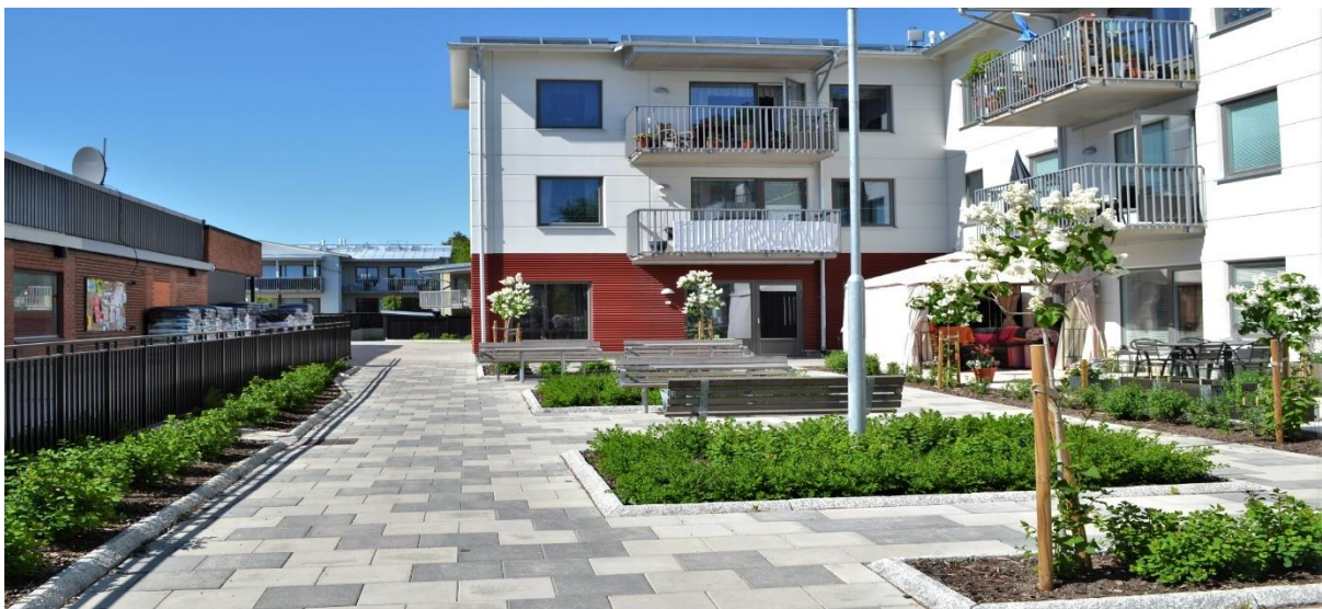
Näckrosvägen 150 med vår största solcellsanläggning
