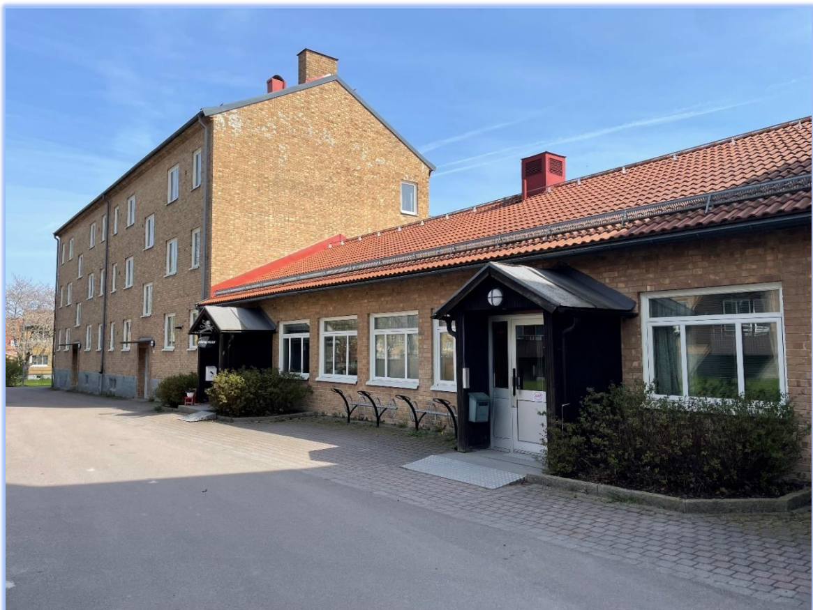
Hästskogatan 1 A-D, första fastigheten där värmekurvan styrs kontinuerligt av en AI programvara.
